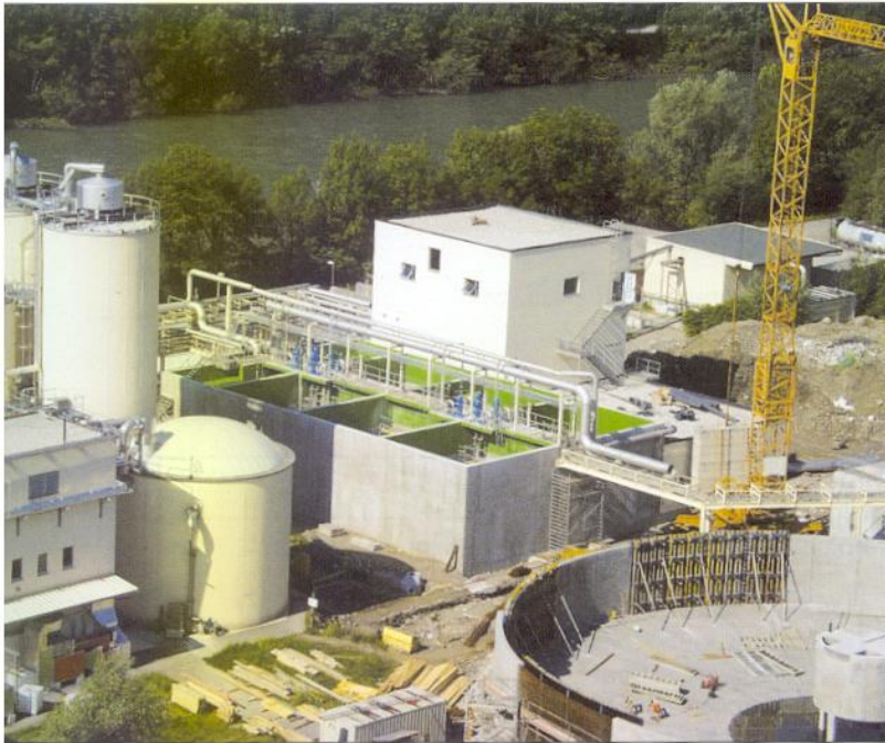
Abwasserklärbecken mit Schlammwässerungsgebäude im Bau
