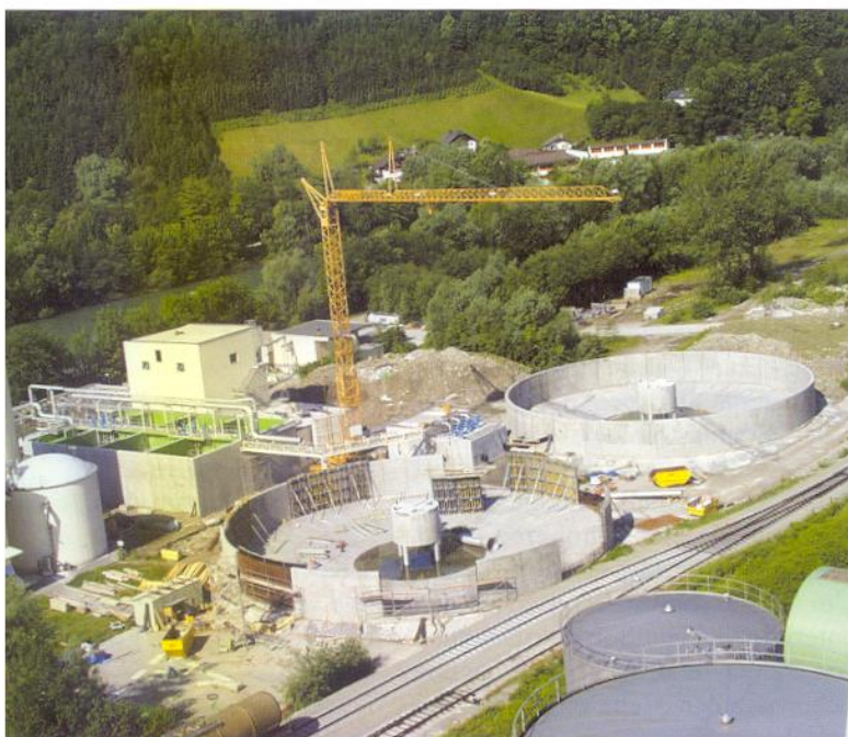
Abwasserklärbecken im Bau
